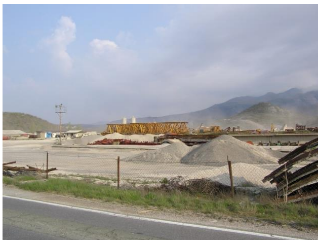
SLIKA 153: NAPUŠTENI POGON HIDROELEKTRE NA KIKOVICI S MNOGIM POTENCIJALNIM IZVORIMA ONEČIŠĆENJA
